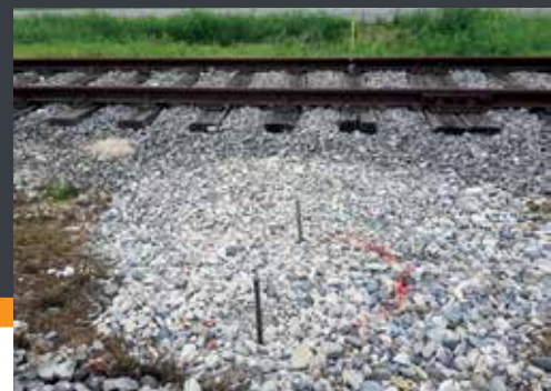
Consolidamento tra i binari
