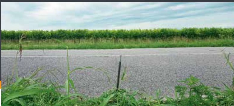
Consolidamento tratto stradale
