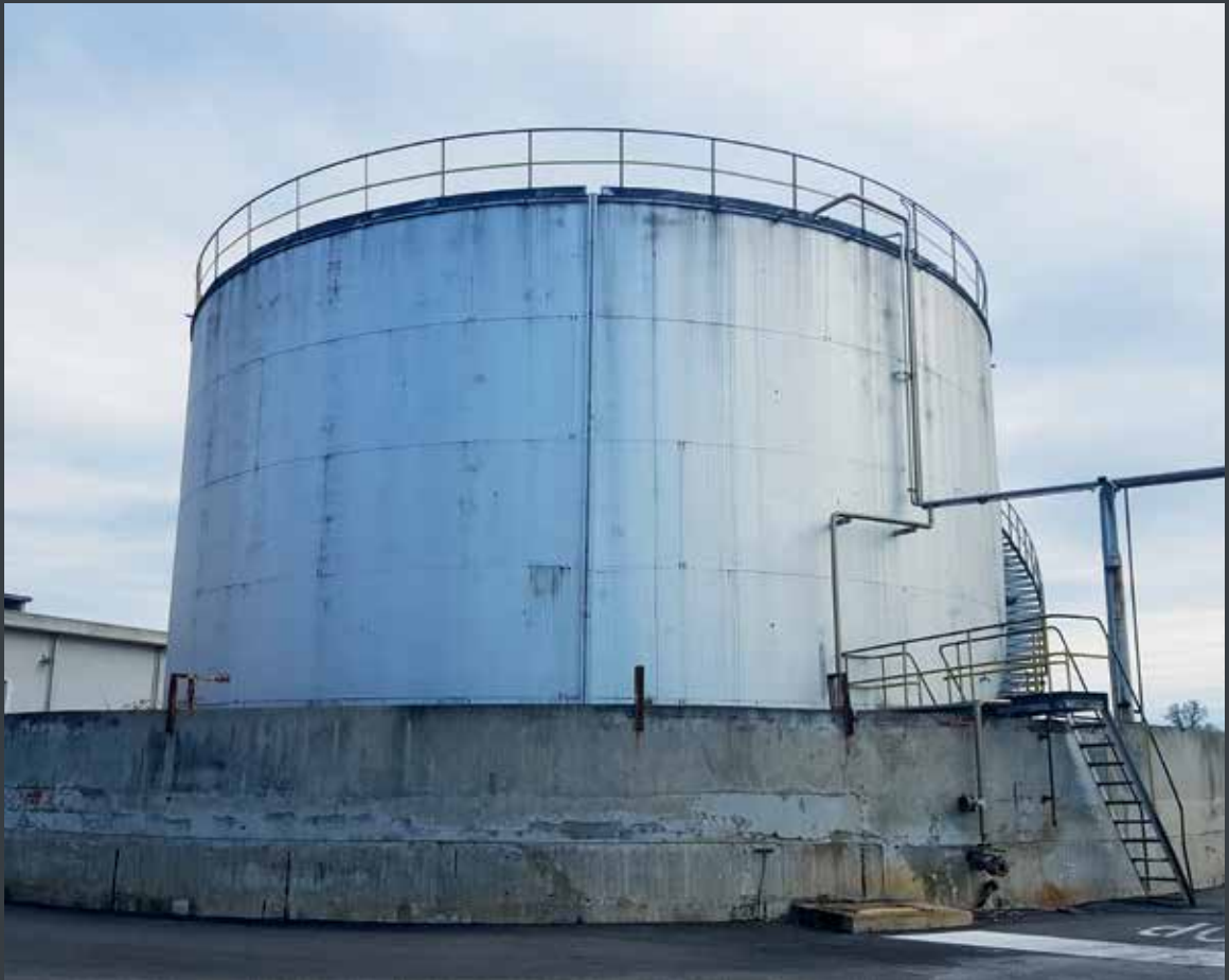
Ripristino pavimentazione di serbatoio riservato al contenimento di liquidi speciali.
